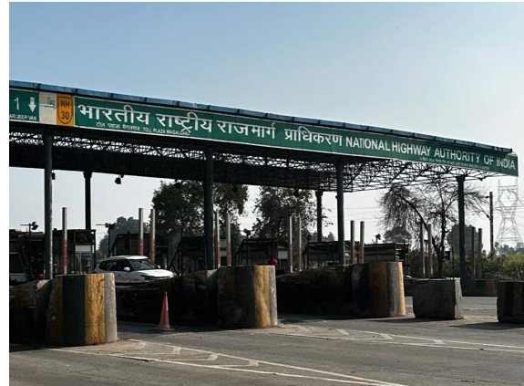
Maigalganj Toll Plaza
