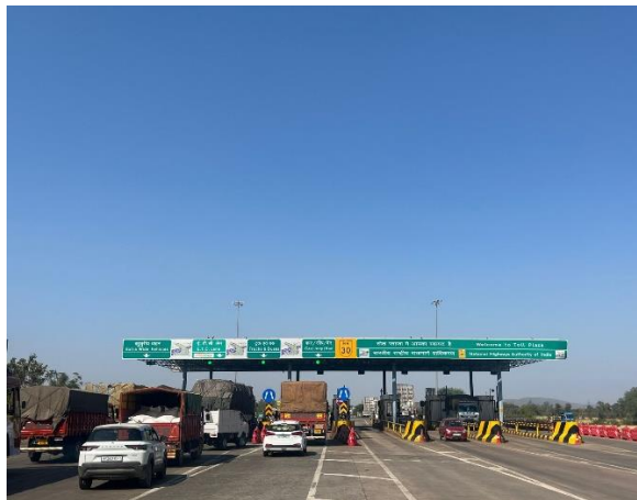
Mohtara Toll Plaza
